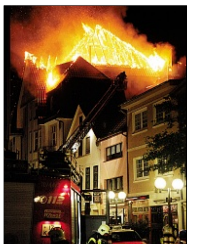
Je älter das Haus, desto gefährlicher: Eine Regel, die sich zuletzt beim Großbrand in der Feldschmiede zeigte.
