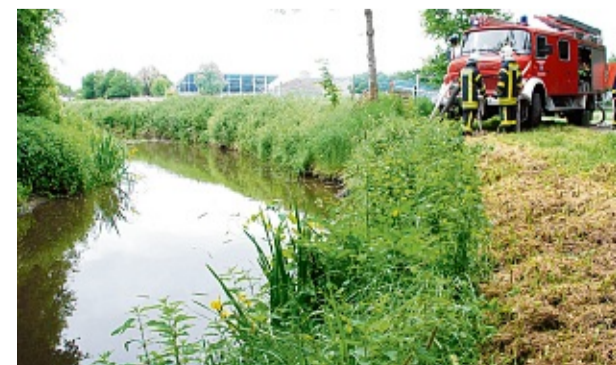
Diese Wetterm bei Süderau drohte überzulaufen und ein benachbartes Wohngebiet zu überschwemmen.
